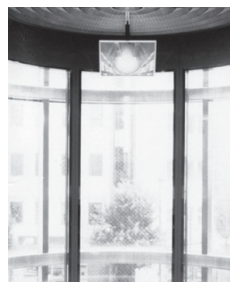
T劇場のエレベータに設置したFFミラー。FFミラーなら外の景観を楽しむと同時に安全に乗降できる。
