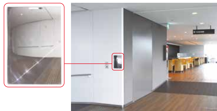
カフェテリアの出入口に設置 (FT23A)
