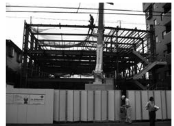
7月11日 躯体工事
