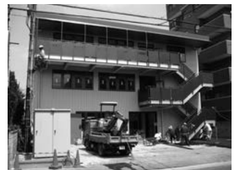
8月29日 アスファルト工事
