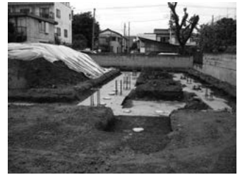
6月9日 基礎工事
