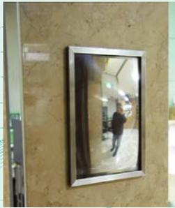
エレベータの三方枠に貼って使うミラー。ミラーを見るだけで乗り込もうとしている人がいないか確認できる。安全な運行と昇降回数の削減に
