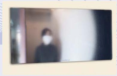
プライバシーに配慮し、人の気配だけが分かるよう鏡面に「ぼかし加工」を施したFFミラー。トイレ通路出入り口の衝突防止に
