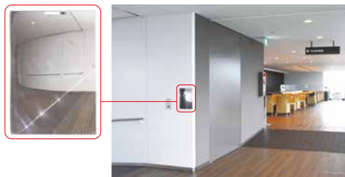
カフェテリアの出入口に設置 (FT23A)
